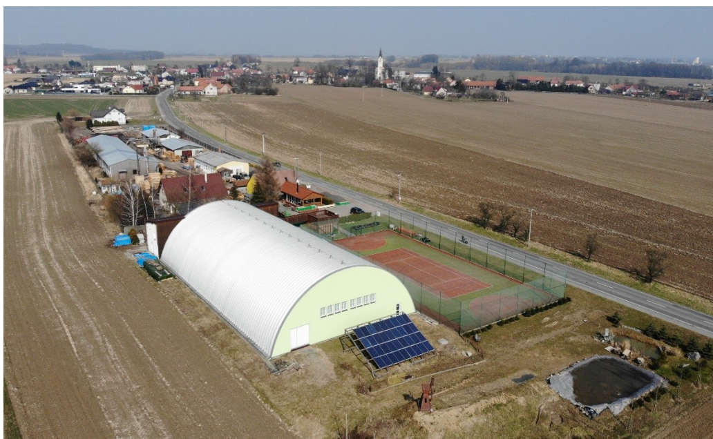
Obrázek 12 Víceúčelová sportovní hala a víceúčelové sportovní hřiště (vlastní zpracování).
